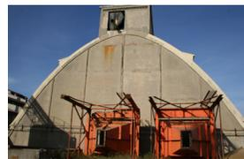
Data de 1960, construído em betão armado com arcos parabólicos, possuindo iluminação zenital. Encontra -se inventariado pelo IPPAR, foi vendido à SECIL.
